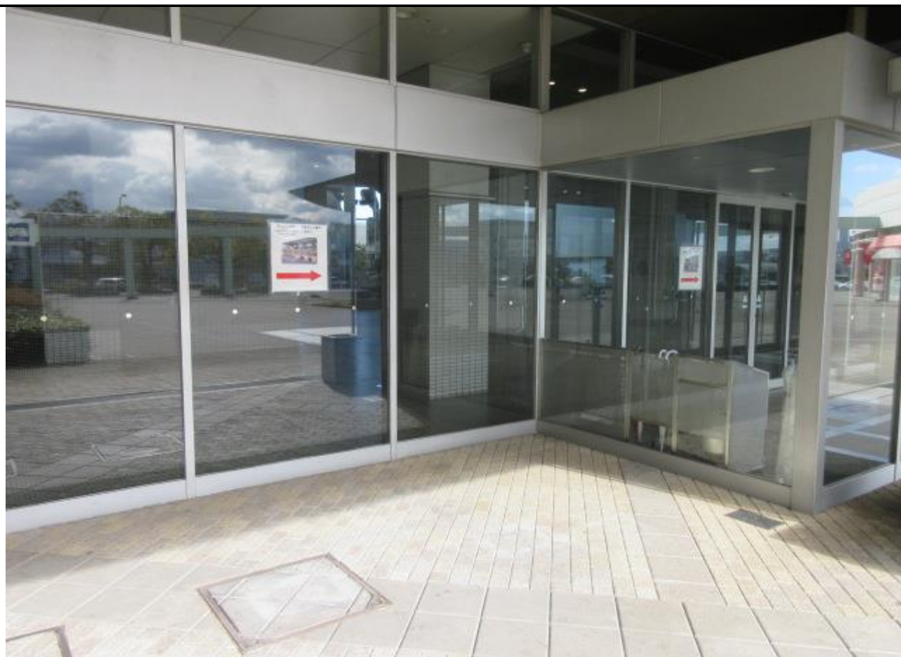
正面入り口横・喫煙所撤去後
